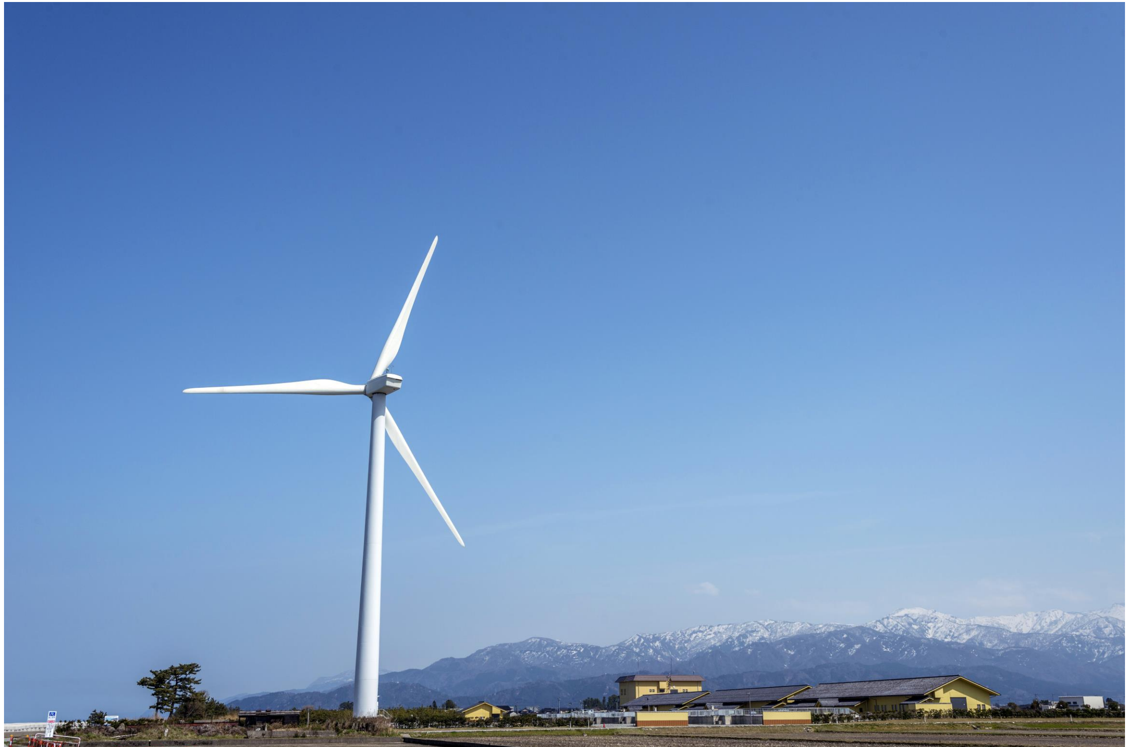
入善町：入善浄化センター風力発電
